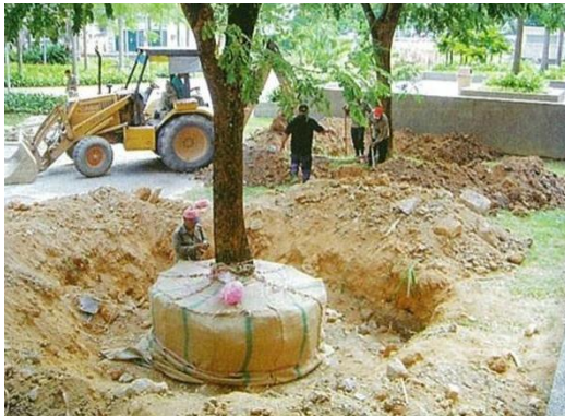
Gambar 26: Kerja-kerja penggalian di tapak.
